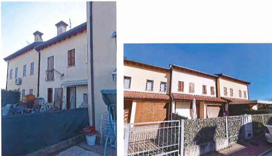
Estratto doc. n. 3-27 _ Documentazione fotografica panoramica dall'esterno
